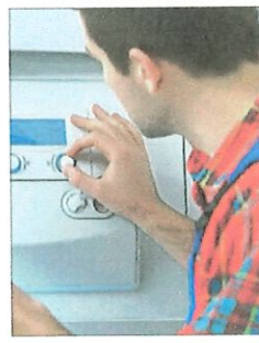
Ein Mann liest den Energieverbrauch an einer Heizung ab. Archivfoto
